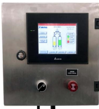
Figura 9 - Exemplo de painel de alarme operacional de uma central de cilindros.
