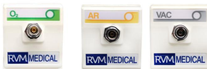
Figura 12 - Postos de consumo individuais de gases medicinais.
